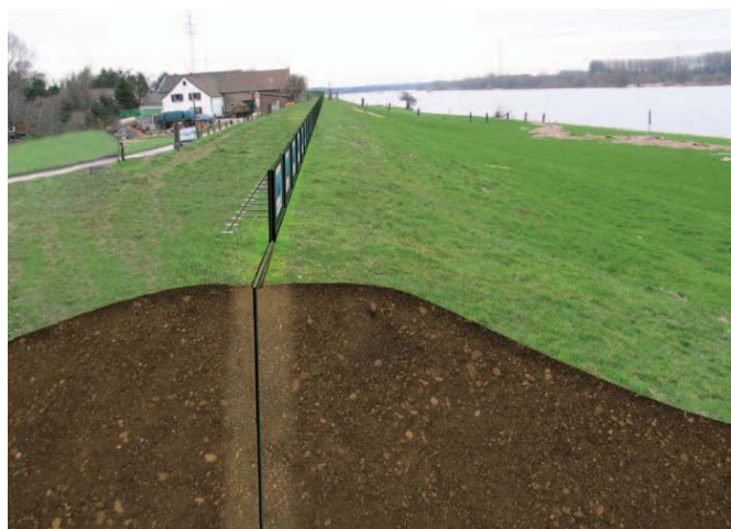
Fig. 2 Le lastre di protezione per argini in polietilene totalmente organico si inseriscono facilmente nell'argine con l'ausilio di lastre mobili di innalzamento, in caso di necessità l'argine può essere innalzato in modo rapido e sicuro.
