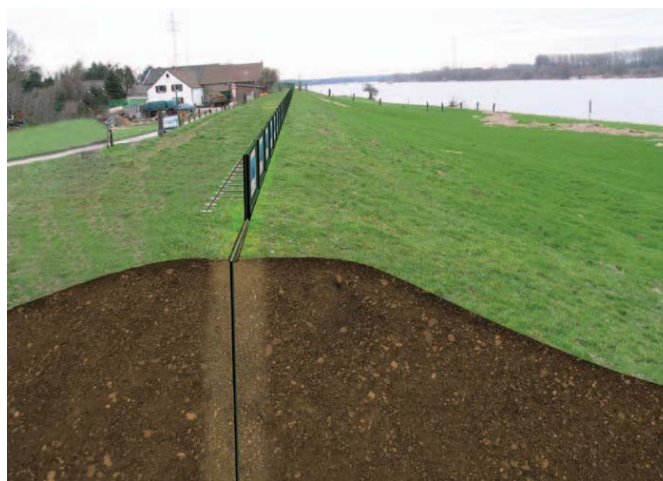
Obrázek 2. Desky pro zajištění hráze z nezávadného polyethylenu lze šetrně zapracovat do stávajících hrází – s mobilními deskami pro zvýšení hráze může být hráz rychle a spolehlivě zvýšena
