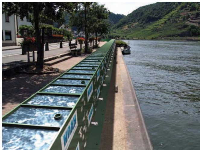
Obrázek 1. Vodou proti povodni: Vanový systém Noah ušetří mnoho času, nákladů a pracovních sil
