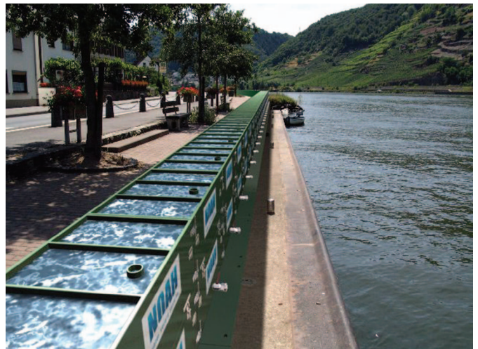
Bild 1. Hochwasser mit Wasser bekämpfen: Das Noah Wannens-System spart viel Zeit, Aufwand und Arbeitskräfte
